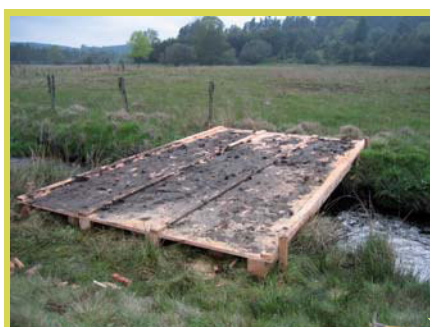
Des planches épaisses (3-4 cm) sur 4 madriers de 15X15 cm sont nécessaires à l'installation d'une passerelle. La longueur varie le plus souvent de 4 à 6 mètres.
