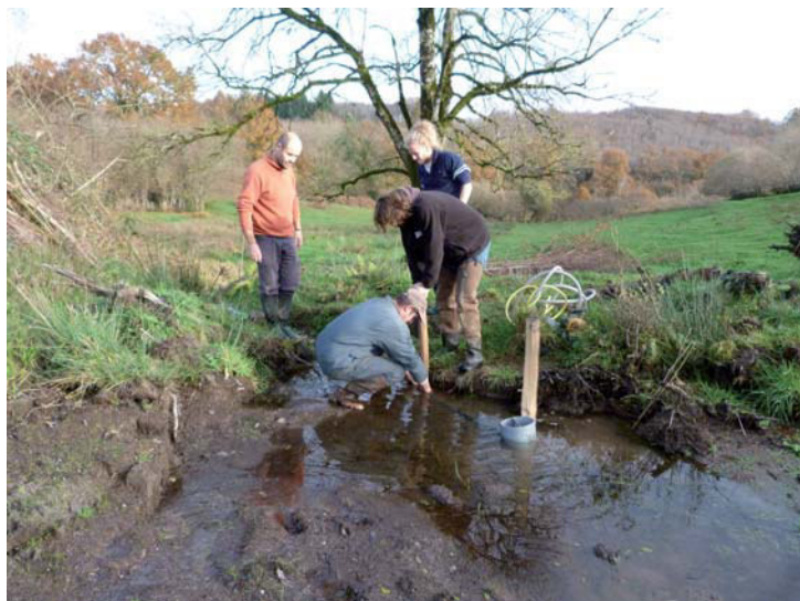
Les animateurs et l'adhérent du RZH installant une prise d'eau sur une pêcherie
