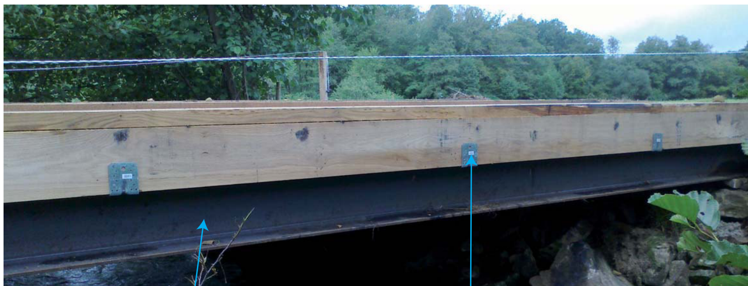
Poutrelle HEA (profil en H couché)
