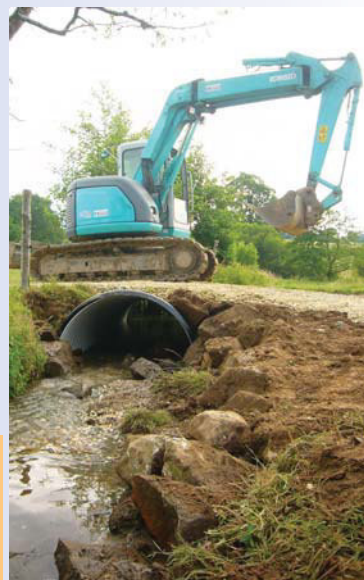
La demi-arche installée ; Cliché François Bontemps – Bocage Mayennais
