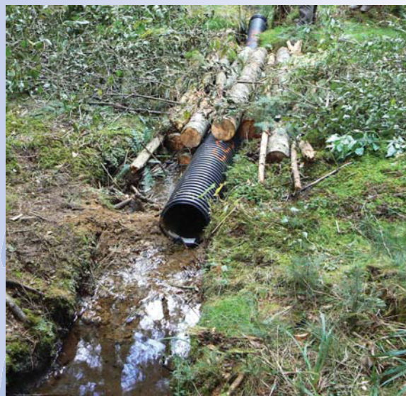
Rondins et tube PEHD dans un ruisseau ; cliché Cécilia Ferté – CREN Limousin
