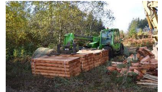
Manitou (déplacement des madriers)
