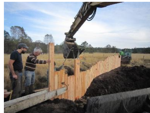
4 - Mise en place des palissades à la pelle mécanique
