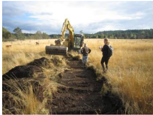
2 - Décapage et réservation de la matière végétale
