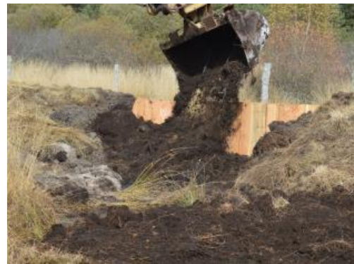
5 - Prélèvement de tourbe en amont pour couvrir les palissades
