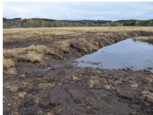
7 - Recouvrement avec la matière végétale
