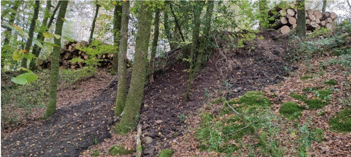
Andain de terre poussé en contrebas du chemin © CEN Nouvelle-Aquitaine
