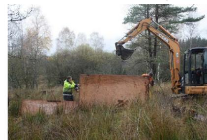
Dans le cadre du programme « Sources en action », le CEN Nouvelle-Aquitaine a réalisé des travaux de neutralisation d'une partie des anciens drains cet automne 2022 : 2 fossés de plus de 300 mètres linéaires cumulés.
