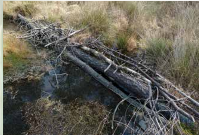
Barrage sur drain
