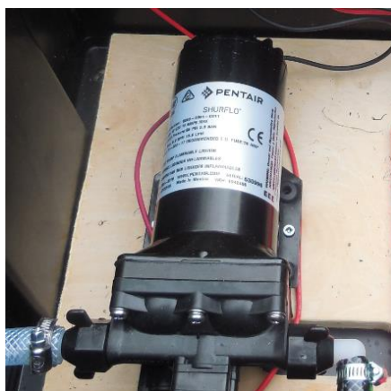
Photographie 9: Pompe de surface SHURFLO en 12 V
