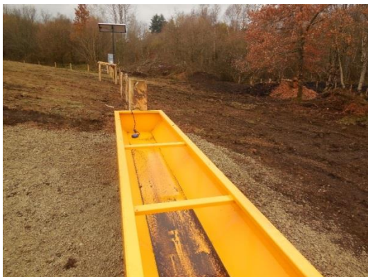
Photographie 11: Abreuvoir avec une auge et un flotteur d'arrêt
