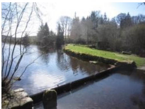
Déversoir en rive droite, avec grilles réglementaires
