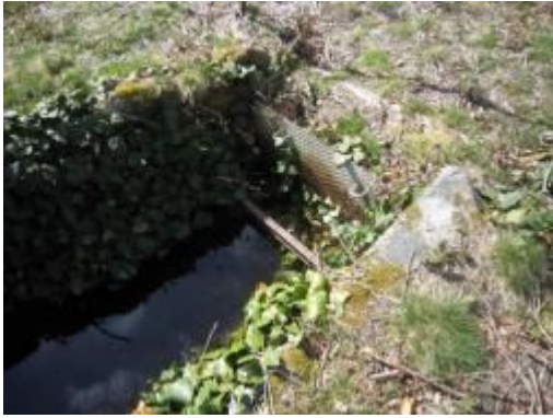
Entrée du canal de vidange
