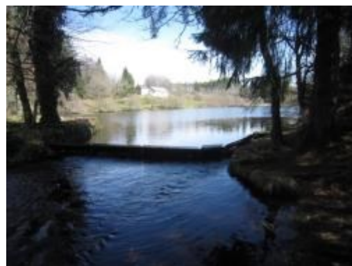
Déversoir en rive gauche, avec grilles réglementaires
