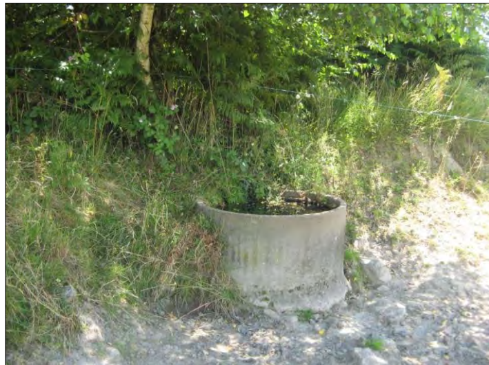
Photo 22 : captage buse béton au niveau de la mare, îlot 24
