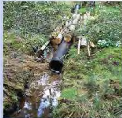
Rondins et tube PEHD dans un ruisseau ; cliché Cécilia Ferté - CREN Limousin
