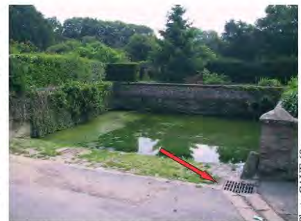
Arrivée d'eau sans traitement préalable
