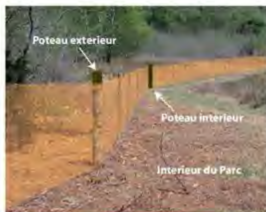
Installation en bonne et dure forme de la clôture fixe
